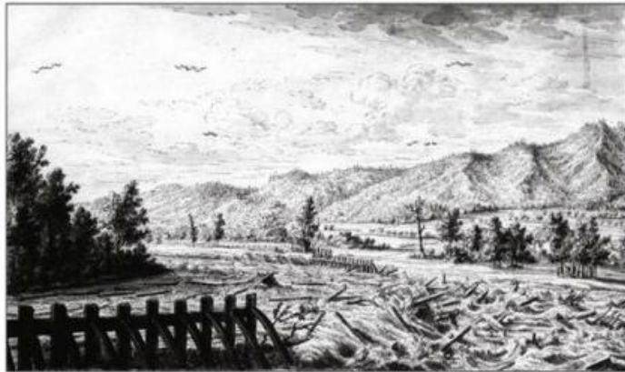
Abb. 8: Das Zürcher Sihlwehr mit aufgesetztem Triftrechen bricht beim Hochwasser von 1732. Zeichnung von Melchior Füssli (Zentralbibliothek Zürich).
